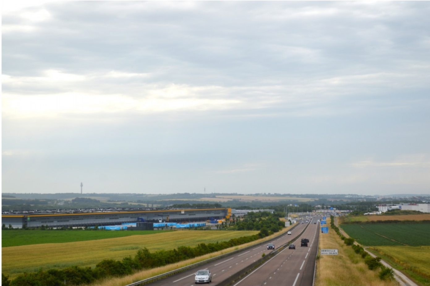
Dynamique urbaine; à la croisée des chemins
