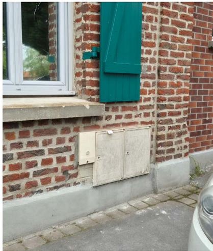
**Photos après travaux de remise en état du soubassement et intégration des coffrets dans les façades**
