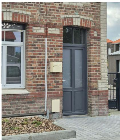
**Photo après travaux de rénovation d'une façade** montrant le travail de dessin des nouvelles menuiseries. Les boîtes aux lettres ont été fixées sur les façades. Les coffrets ont été intégrés aux façades.
