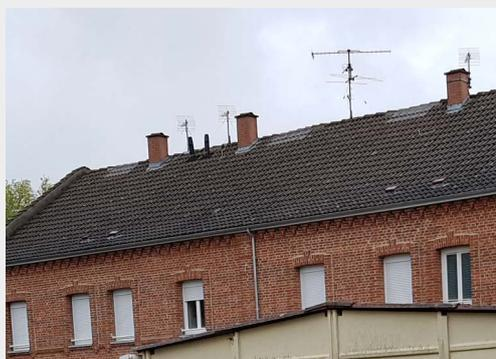
**Photo des réfections de toitures** faites après la dépose des souches de certaines cheminées par la pose de tuiles de couleur brune au début de la phase chantier, comme les tuiles existantes.
