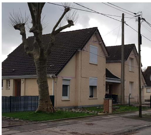
Photo avant travaux de rénovation illustrant les volets roulants posés en saillie
