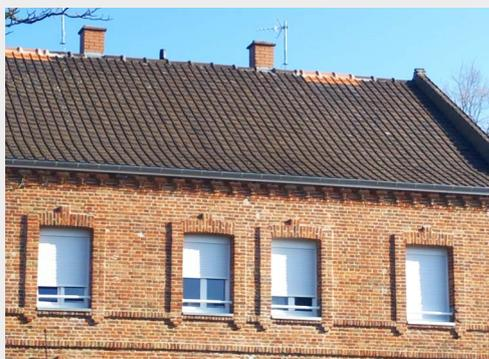
**Photo des réfections de toitures** faites après la dépose des souches de certaines cheminées par la pose de tuiles de couleur orange, différente de celle des tuiles existantes.
