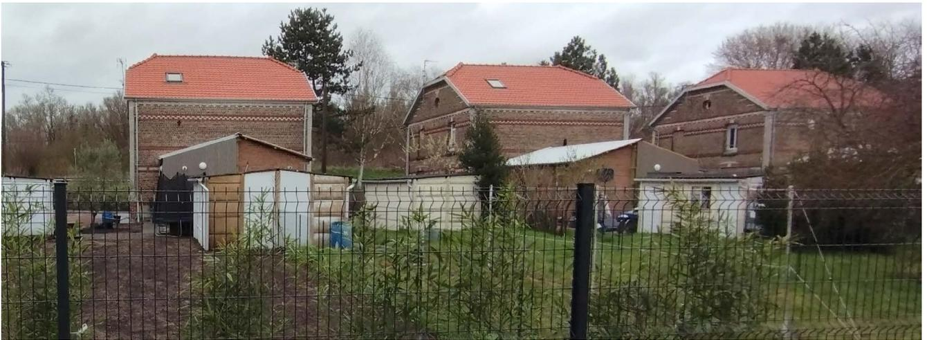
Photo sur les toitures où les tuiles en béton ont été remplacées par des tuiles en terre cuite couleur rouge flammé.
