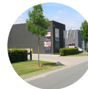
Esserstraat, un parc d'activité en zone, résidentielle, Zwevegem (B)
