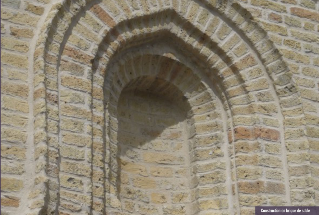
Construction en brique de sable
