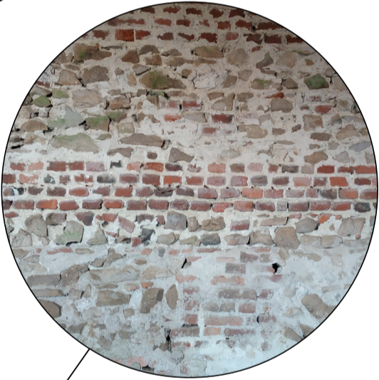
Appareillage brique existant
