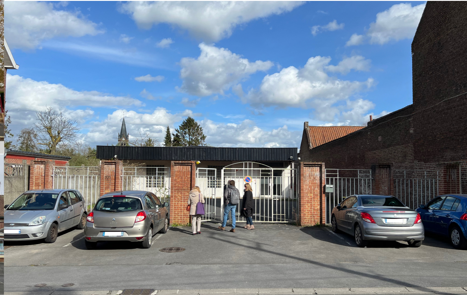
L'ancien magasin vu depuis la rue de la Paix
