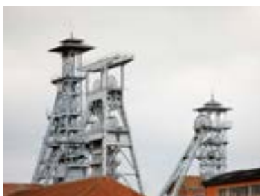
Bassin minier du Nord-Pas de Calais, France bassinminier-patrimoine mondial. org/les-chevalements/
