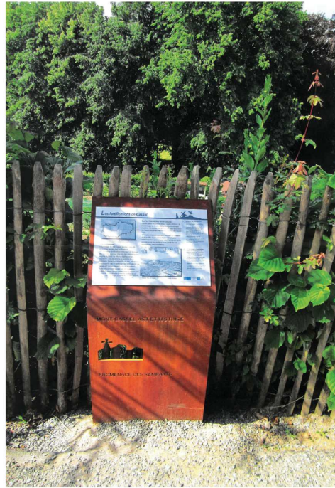
Exemple de support du panneau pédagogique en acier corten avec une découpe pour le logo de la ville. L'impression du panneau se fait sur Reglit puis fixé sur le support en corten, ou équivalent.
