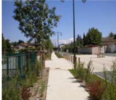
Traversée de bourg : bas côtés enherbés servant à recueillir les eaux de ruissellement, cheminement piéton perméable et accessible PMR.
