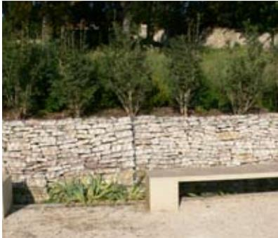
Des murs en gabion à mettre en oeuvre avec des pierres locales ou matériaux récupérés (briques de bâtiments voués à démolition).
