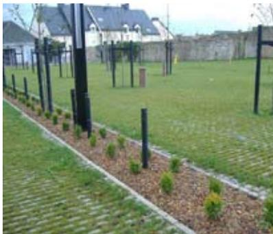
Hiérarchiser les espaces et adapter les revêtements de sols en fonction : les parkings peuvent être des surfaces en herbe ou perméables.
