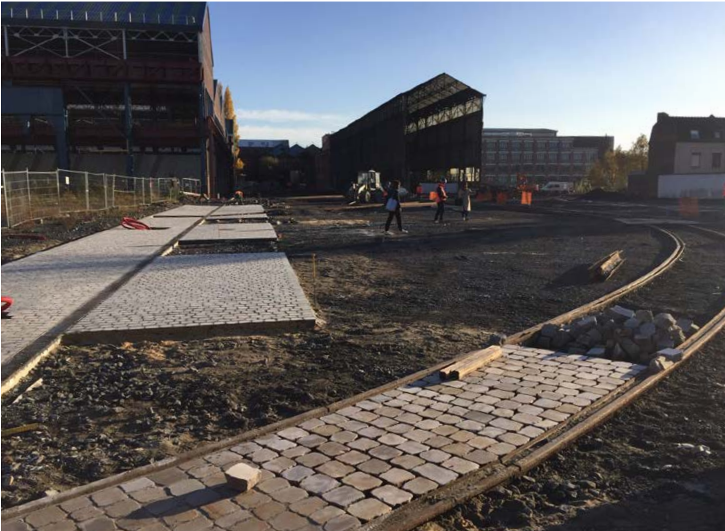
Cour Ouest en travaux _ automne 2018
