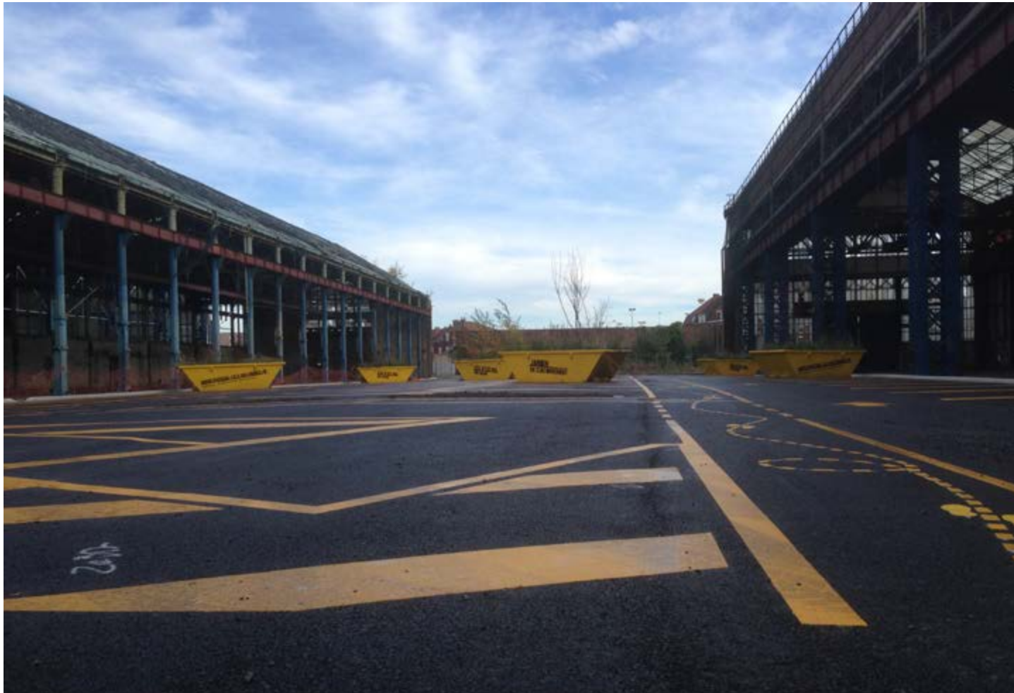
Parking provisoire déplacé, en cours de travaux _ automne 2018
