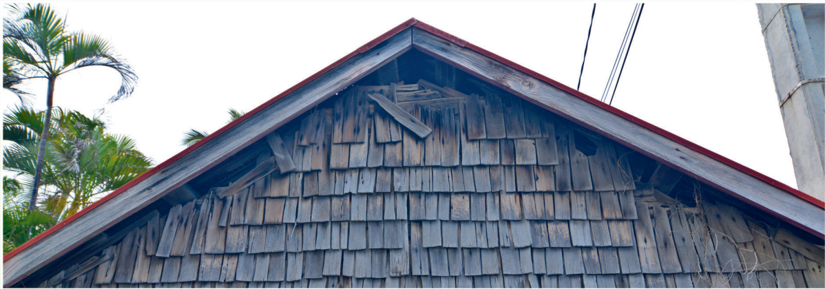
BARDEAUX DE FACADE EN FIN DE VIE
