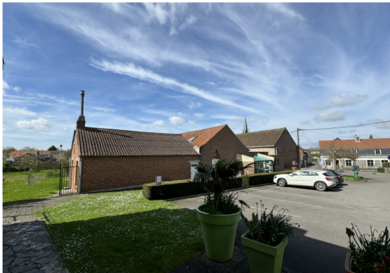
La mairie occupe un ancien corps de ferme, en articulation avec l'arrière de l'école (à gauche), le presbytère et son jardin et l'accès au tour d'église (sur la droite).
