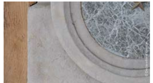
Décapage de la façade et restitution de l'apparence d'origine des matériaux
