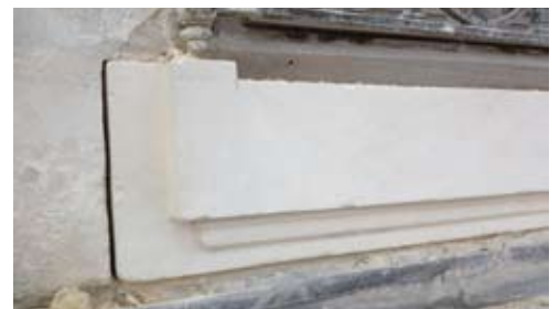
Remplacement de la pierre d'appui en tiroir
