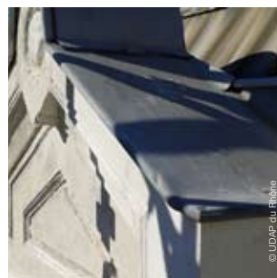
Exemple d'une bonne protection des ouvrages en pierre
