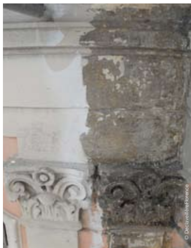
Décapage en cours
