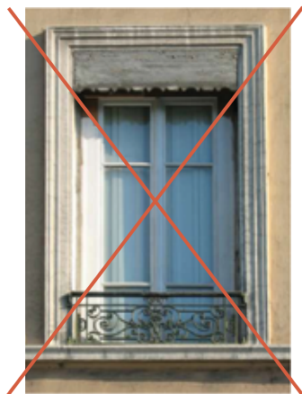
Menuiserie de type rénovation, la présence d'un double dormant
