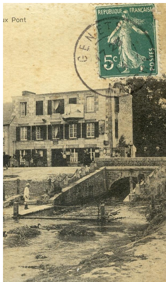
Exutoire de la Lerre au niveau du pont de Genêts
