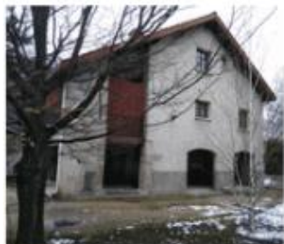
2021 Seyssinet / Maison individuelle EPFL Dauphiné • Déconstruction sélective
