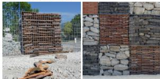
Déchetterie Saint Martin d'Hères_ NA architecture_2018
