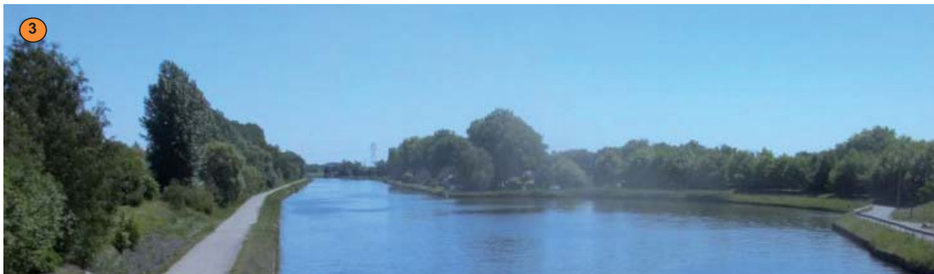
Corridor écologique le long du canal de la Deûle (Dourges).
