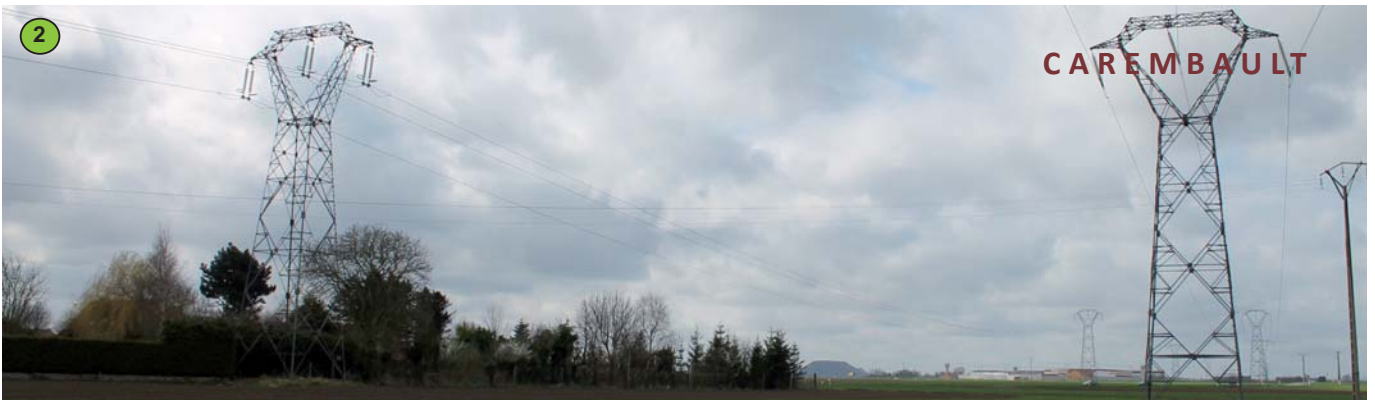
Corridor électrique assez étroit entre Carnin et Annoeullin.
