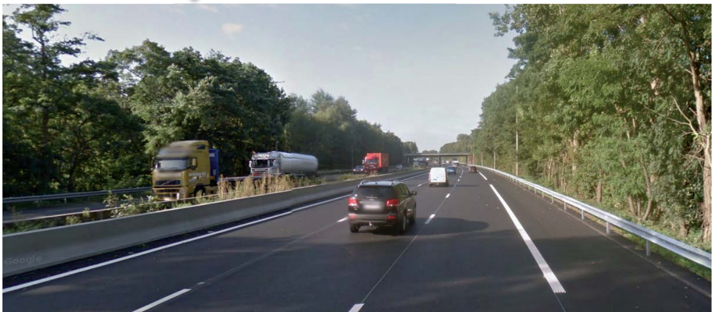
Autoroute A1, traversée du bois d'Épinoy.
