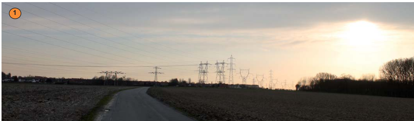
Attiches, passage de la ligne électrique en lisière du Bois d'Avelin.
