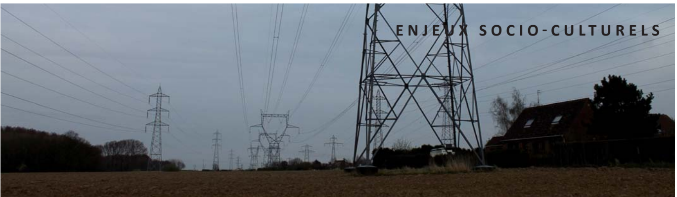
Corridor de lignes à haute tension à Avelin et surplomb d'habitations. La pression visuelle et psychologique est très forte.
