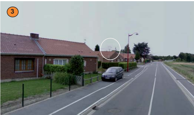
Auby, cité de la Justice site classé comme « Bien UNESCO », la ligne électrique passe à l'ouest de la cité. L'impact visuel est assez marqué hors de la cité mais dans les rues internes il est très limité par le cadre bâti.
