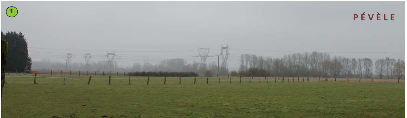
Ligne électrique à Avelin
