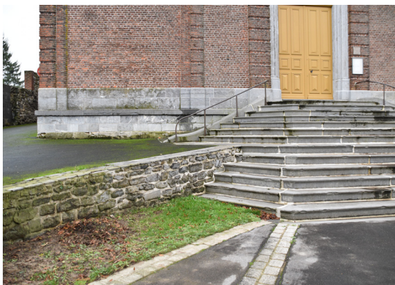
Enmarchements parvis de l'église. Source : photo personnelle
