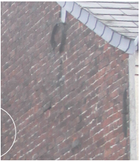
Trace d'un ancien bâtiment contre la grange
