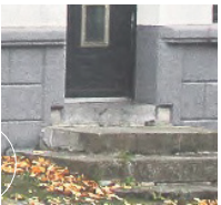
Soubassement en pierre de taille peint Emmarchement en pierre bleue
