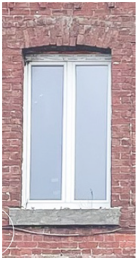
Fenêtre linteau citré en brique Linteau et clé de voute en brique
