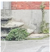
Élément structurel en pierre bleue : soubassement, em- marchement, appui de fenêtre
