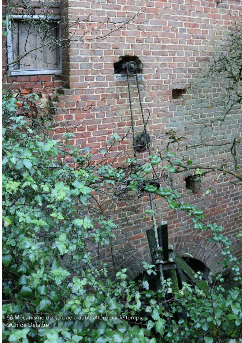
66 Mécanisme de la roue à aube altéré par le temps
