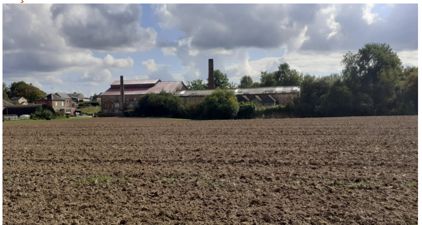
Visibilité des bâtiments en extension.
