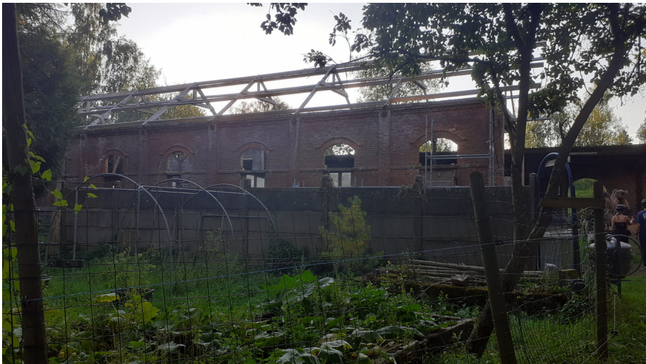
Halle survivant de la verrerie du bas.
