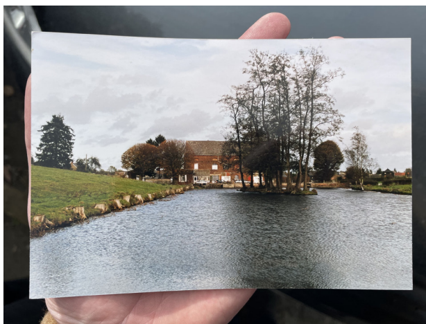
Photo de l'étang avant dégradation de la vanne.
