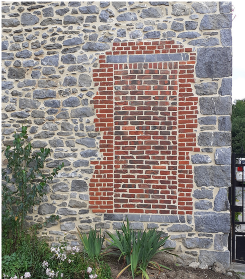
Un exemple de remplissage à l'aide de briques d'ancien four.
