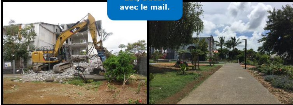
Pendant les travaux
