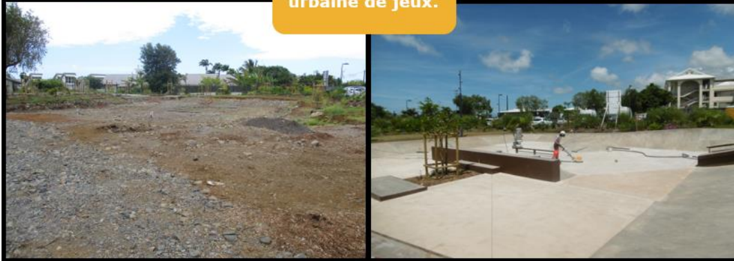
Pendant les travaux
