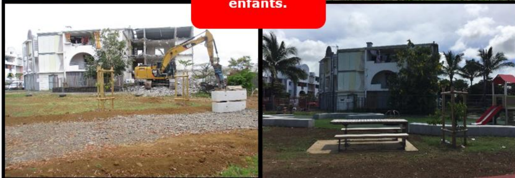
Pendant les travaux
