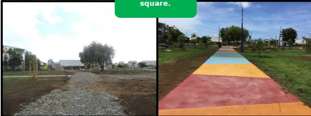
Pendant les travaux
