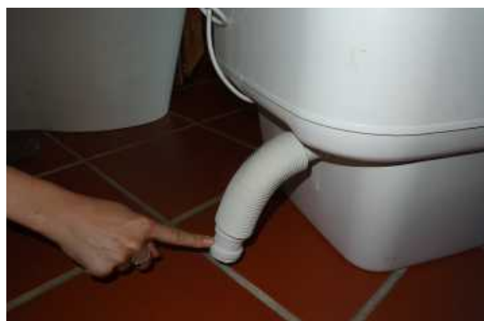
Mise en place du siphon sec à la sortie des urines
