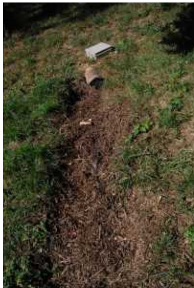
Filtre rempli de broyat
