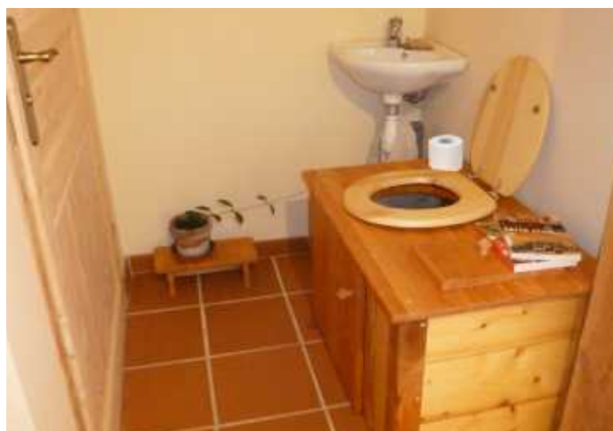
Photo des toilettes installées
