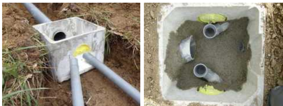
Figure 10 : Un regard répartiteur découpé à la meuleuse avant (à gauche) et après (à droite) étanchéité
