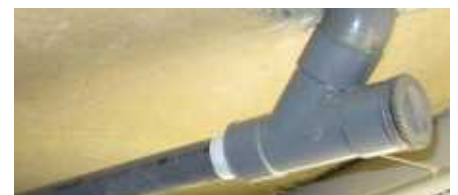
Y avec bouchon permettant le nettoyage des canalisations
