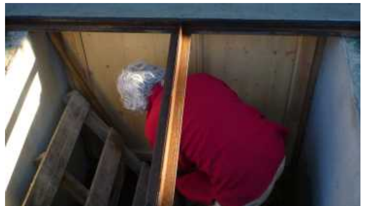
Photo de la menuiserie étanche derrière la trappe
