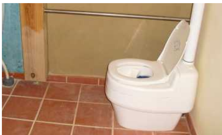
(en haut) Vue sur l'obturateur en bleu et la lunette séparative du modèle Separett
