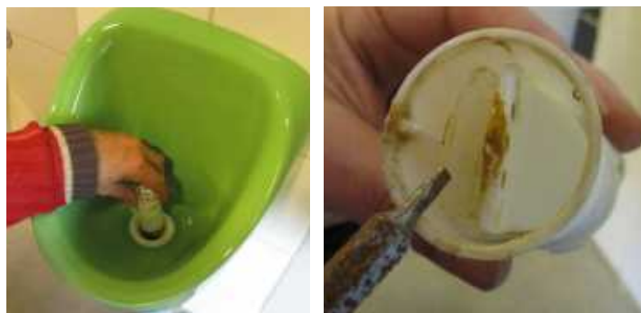
Démontage du siphon sec et nettoyage de la membrane
