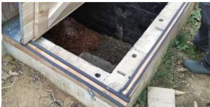
Joint sur trappe d'accès pour l'étanchéité à l'air
