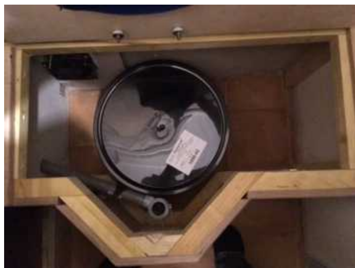
Vue sur l'évacuation des urines et le réceptacle des matières une fois l'assise levée.
