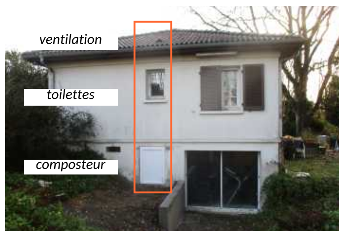
Façade nord de l'habitation avec accès au composteur
