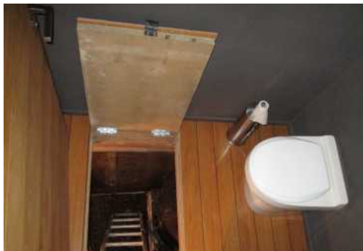
Photos de la pièce des toilettes vue d'en haut avec la trappe fermée puis ouverte
