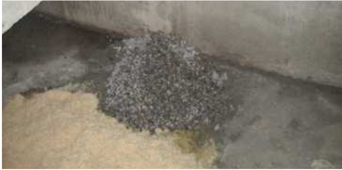
Pose de cailloux sur la sortie des lixiviats
