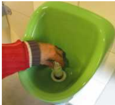
Démontage du siphon sec
