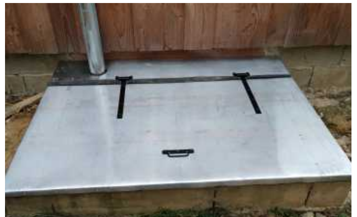
Façade nord de l'habitation avec accès composteur
