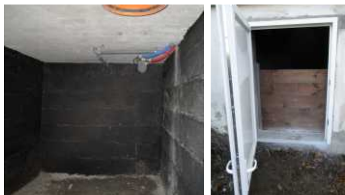
Composteur : murs intérieurs étanchéifiés et batardeau derrière porte d'accès
