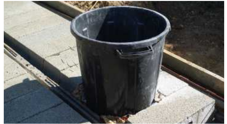
Réservation avec une poubelle dans le hourdis béton
