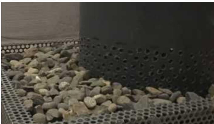
Tuyau en PVC percé et drainage en cailloux autour
