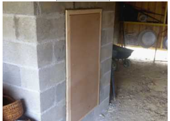
Dessin (face) et photo d'un composteur relié à une toilette, construit dans un sous-sol. Accès par une porte.
