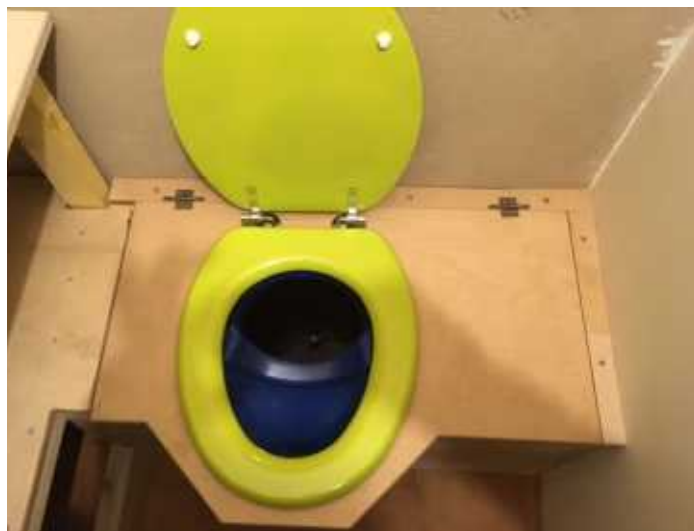
Photo de l'assise des toilettes avec la lunette séparative. L'assise se lève pour que la vidange du réceptacle ne soit pas gênée par le tuyau des urines.
