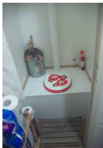
(à gauche) Toilettes sèches unitaires pour une famille avec réceptacle de 80 l
