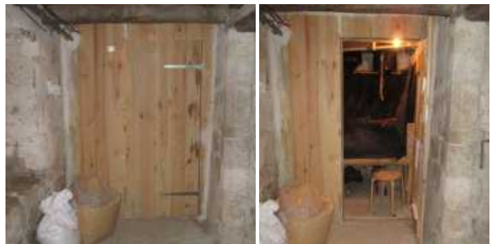
Photos : le composteur est dans une cave (murs existants en pierre) fermé par une cloison et une porte en bois comprenant des joints
