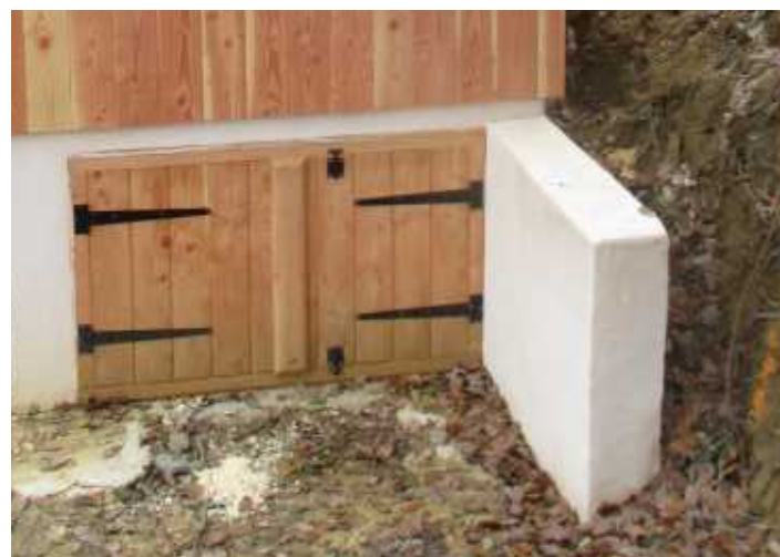
Photo d'un accès au composteur avec construction d'un muret de soutènement
