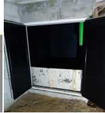
Plans et photos d'un composteur relié à une toilette avec un accès par une menuiserie étanche à double vantaux avec batardeau (amovible)
