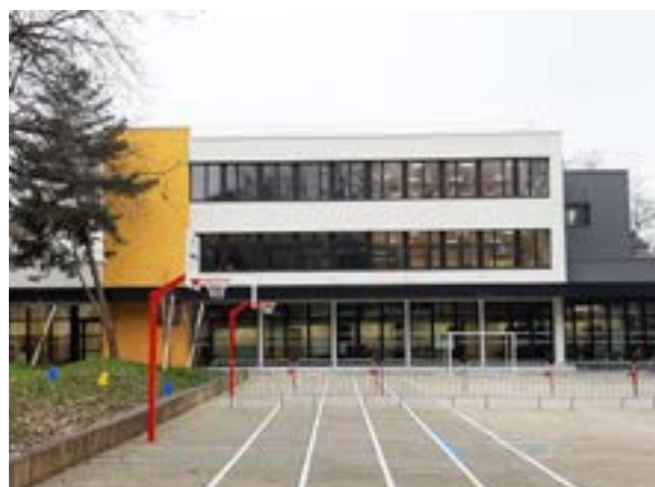
Le groupe scolaire rénové
