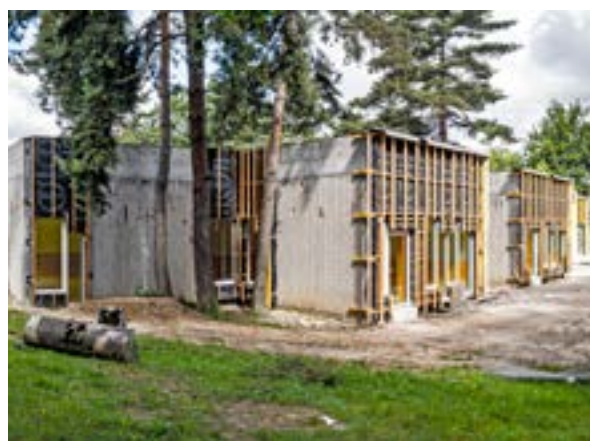
Une isolation thermique par l'extérieur a été préconisée
