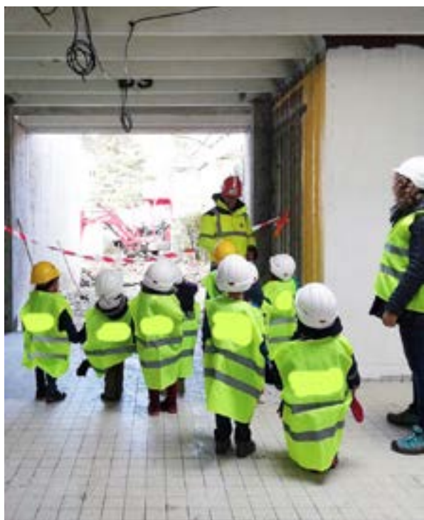
Visite du chantier avec les enfants
