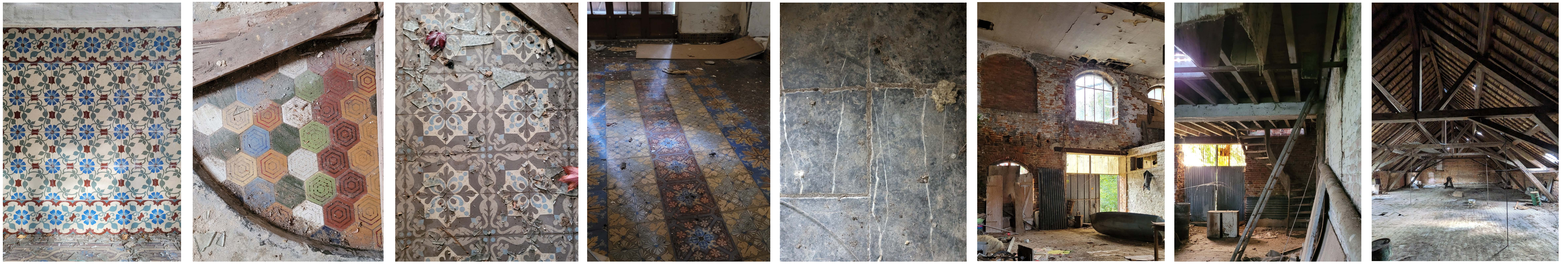
Éléments remarquables à conserver : les différentes céramiques, la pierre bleue au sol en R-1, la double-hauteur, la charpente.
