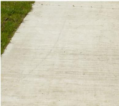
Béton coulé / finition désactivée
