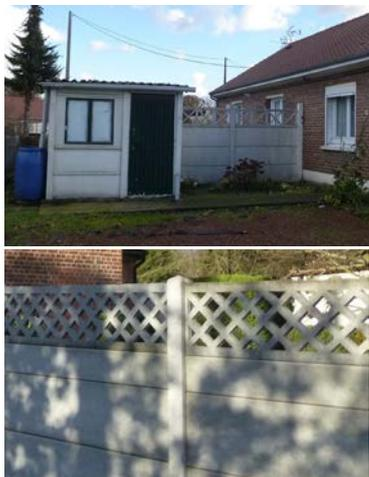
Mur d'intimité en plaques béton sur la cité Pinson Nouvelle => continuité visuelle avec la remise en béton
