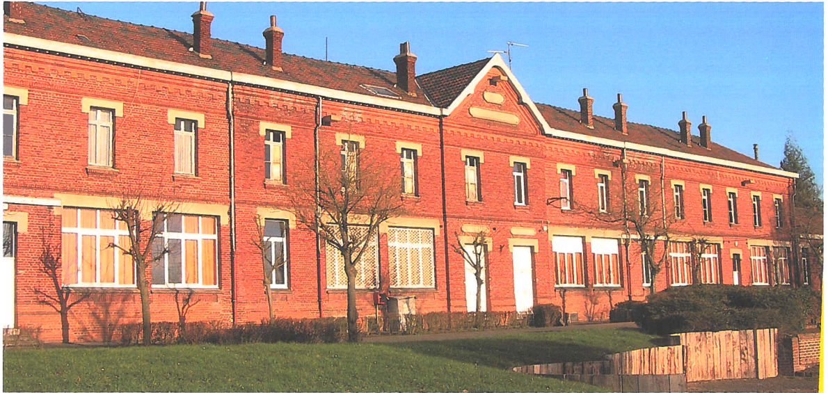
Façade monumentale de l'école de la cité du Pinson. © Mission Bassin Minier
