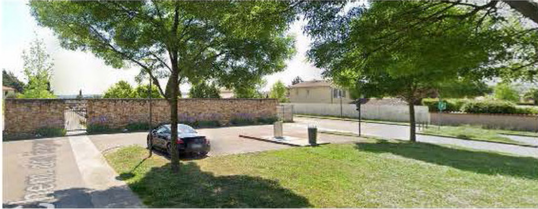
1 REQUALIFIER LE MUR D'ENCEINTE DU CIMETIERE
