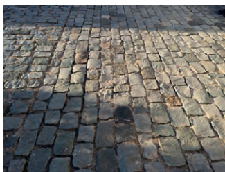
À Sète (34), le parvis et l'allée principale sont en pavés de pierre naturelle posés sur sable et les contre-allées en gravillon, malgré la pente.
