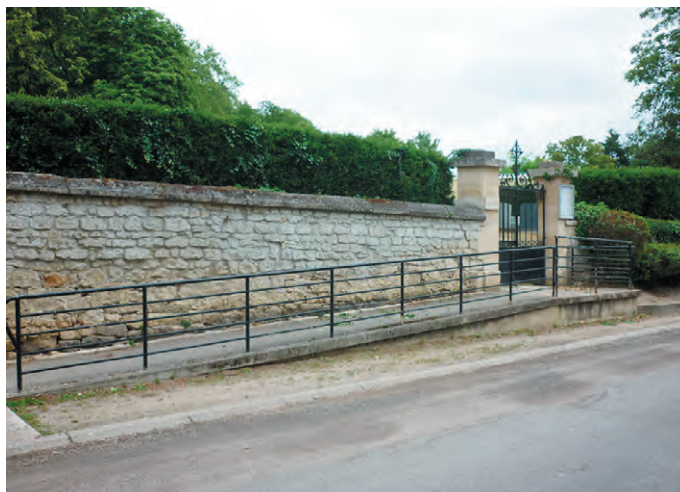
Rampe d'accès au cimetière d'Aumont-en-Halatte (60) ménagée malgré l'exiguïté du site. Le dispositif pourrait être optimisé par une étroite plantation de vivaces en limite du trottoir au pied de l'ouvrage.
