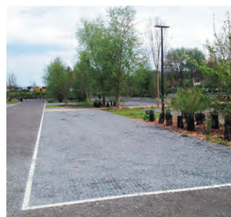
Sol mixte en émulsion gravillonnée et gravillons.
