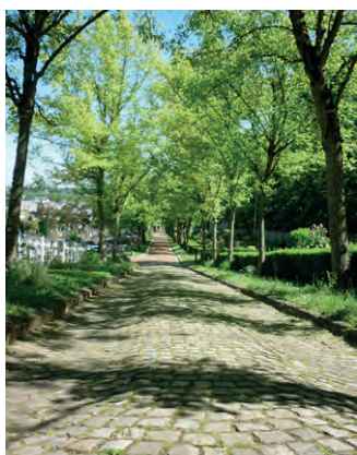
Cimetière des Gonards à Versailles (78) : allée en pavés de grès, avec forme bombée pour rejeter les eaux de ruissellement contre les bordures latérales des anciens trottoirs, qui ont été enherbés.
