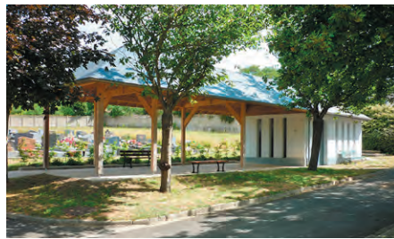
Ce nouveau bâtiment d'accueil, avec une salle de recueillement, a été implanté contre l'allée principale de l'extension du cimetière de Vaux-sur-Seine (95).
