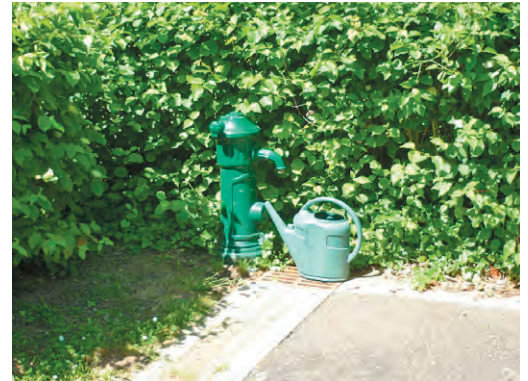
Au cimetière de Guyancourt (78), un dispositif régulièrement rencontré : une fontaine traditionnelle en fonte disposée aux angles des carrés du cimetière et associée à un avaloir pour récupérer les eaux.
