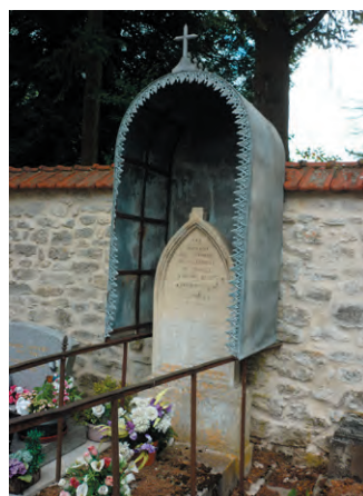
Petite couverture en zinc protégeant une stèle au cimetière de Vineuil-Saint-Firmin (60).
