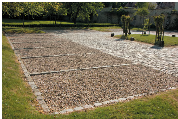
Aire de stationnement du Parc du Château à Hardricourt (78). Le sol associe le pavé de grès posé à sec (sur lit de sable) et le gravier. Les bordures en pavés sont scellées mais les joints sont "à reflux" pour laisser l'eau s'écouler. Photo : A. Pedzol.
