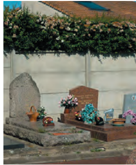
Mur en palplanche de béton. Un adossement dévalorisant. Cimetière des Clayes-sous-Bois (78).
