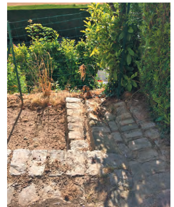
Jeu de caniveaux en pavés de grès au cimetière de Saint-Vaast-de-Longmont (60) évacuant l'eau vers l'extérieur.
