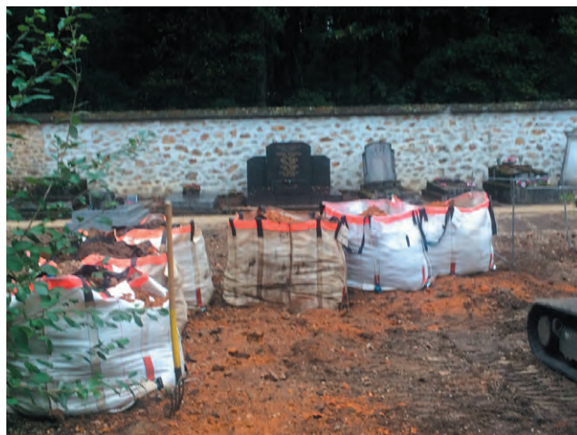
Stockage de terres de fouille par l'entreprise de fossoyage. Cimetière de Boissettes (77).
