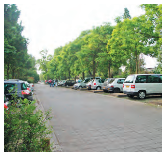
Dallage en pavés béton datant des années 1990. Parking du Parc Floral de Vincennes (94).
