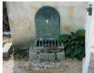
Auvers-sur-Oise (95) : borne fontaine murale en fonte, sur un support en pierre.
