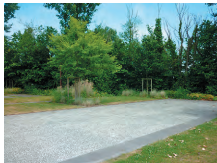
Parking du Mont-Saint-Michel (50). L'accès central est en béton et les emplacements, en mélange terre-pierre, sont ponctués de bandes arborées.
