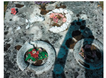
Ornements en cours de désagrégation au cimetière de Pontpoint (60).
