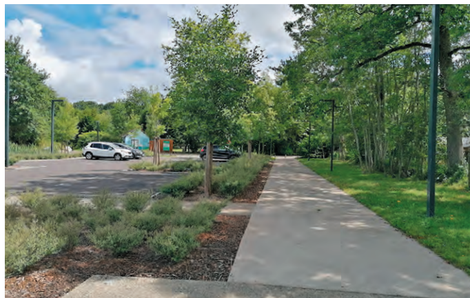
Parking du nouveau cimetière paysager de la Teulère à Lescar (64). Une mare est aménagée au fond du parking pour récupérer les eaux de ruissellement.
