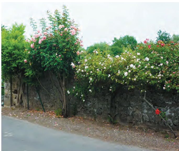
La face extérieure du mur est agrémentée d'une petite collection de rosiers grimpants. Cimetière de Plailly (60).
