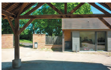
Cimetière de la vallée aux Dames à Verrières-le-Buisson (78) : placette d'accueil avec halle centrale et bâtiment d'accueil.
