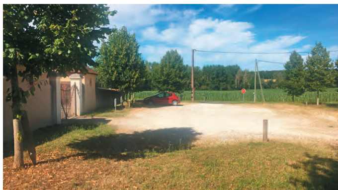
L'aire de stationnement du cimetière de Lurais (36) est une simple esplanade en stabilisé, sans bordure, ce qui permet à la prairie de conquérir les emplacements. Des tontes régulières permettent de réguler la végétalisation naturelle.
