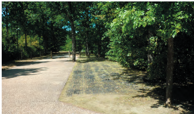
Parking du cimetière de Frédeville à Saint-Jean-de-Bray (45). Le parking principal, près de l'entrée et plus utilisé (photo de gauche), est en béton et enrobé, alors que les espaces plus éloignés sont végétalisés avec un renforcement en "nid d'abeille" (photo prise en période de sécheresse).
