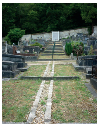
Cimetière de Valmondois (95) : jeu de lignes en pavés et emmarchements en pierre bloquant le sol enherbé. Un caniveau drainant rempli de graviers recueille les eaux de ruissellement et les conduit plus en aval, hors du cimetière.
