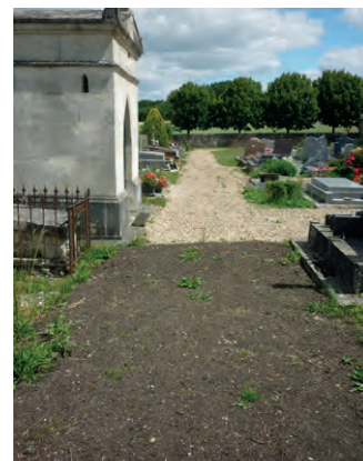
Sol en bois déchiqueté à Corneilles-en-Vexin (95). C'est une bonne solution de sol drainant, confortable et peu coûteux. Pour éviter la repousse des herbes il faut assurer un régilage tous les ans.
