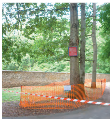
Protection de grands arbres lors de travaux au cimetière de Boissettes (77).
