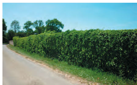
Mur en palplanches végétalisées (ici du lierre) au cimetière de Ferrières (60).
