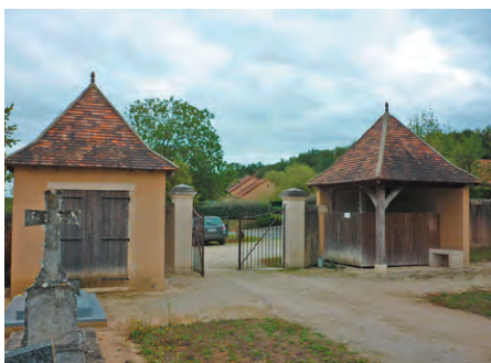
À Lurais dans l'Indre (PNR de la Brenne), lors de la rénovation du cimetière, un des pavillons d'entrée a été adapté pour y loger les conteneurs du tri sélectif, derrière une palissade en bois.
