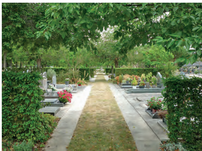
Allée en pelouse renforcée par des dalles alvéolées en résine et bordée latéralement par des dalles préfabriquées en béton. Cimetière de l'Ouest à Angers (49).
