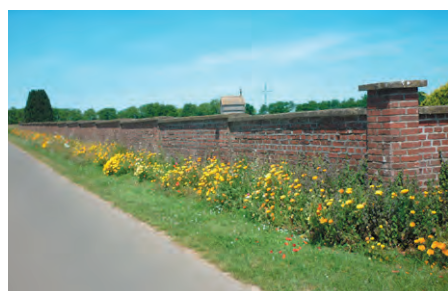
Mur en brique autour du cimetière de Domfront (60).
