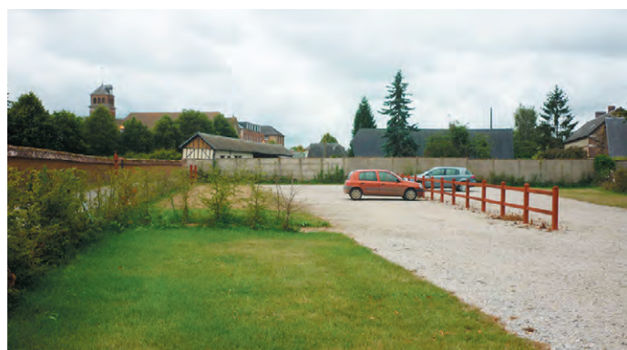
Exemple de parking "mixte" avec un dispositif plus extensif en chambre végétale sur les parties les moins utilisées. Une simple barrière disposée le long de l'axe central indique les modalités du stationnement courant, plus intensif, qui se fait sur un sol en stabilisé. Parking du château, Le Mesnil-en-Ouche (27).
