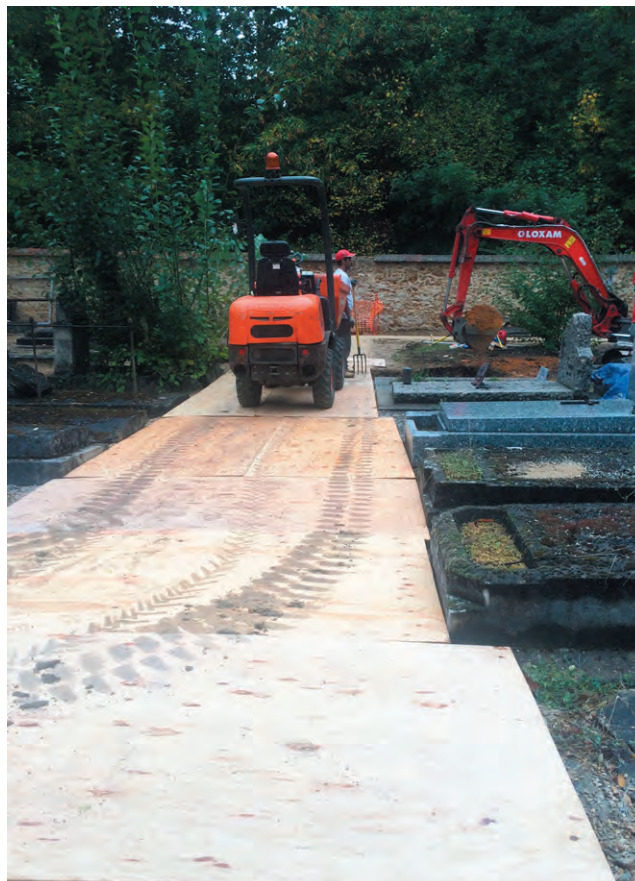
Mise en place de plaques de contre-plaqué par l'entreprise de fossoyage. Cimetière de Boissettes (77).
