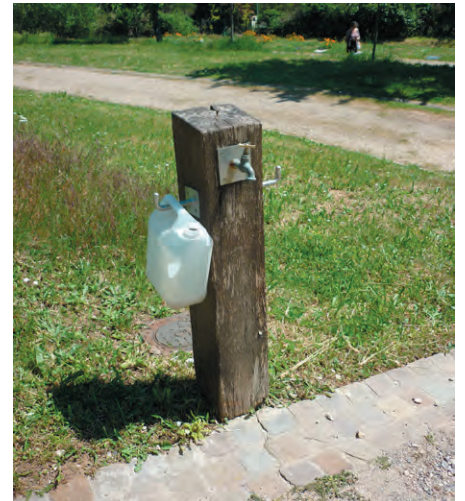
Au cimetière de Verrières-le-Buisson (91), une simple borne en bois et un caniveau en pavés de grès.
