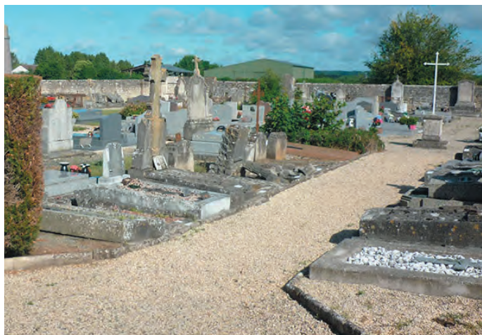
Le revêtement en gravier peut être inapproprié pour le déplacement des personnes à mobilité réduite quand son épaisseur dépasse 3 cm, cimetière de Barbery (60).
