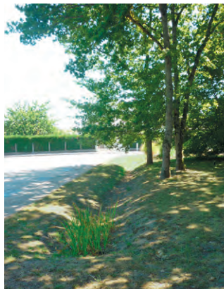
Petite noue d'infiltration des eaux à l'entrée du cimetière de Frédeville, Saint-Jean-de-Bray (45).
