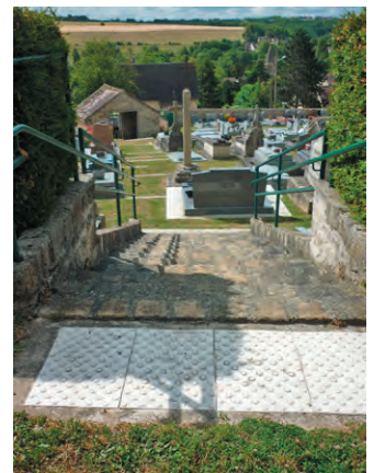
Le cimetière de Tessancourt (95) présente, en raison des pentes naturelles, une configuration complexe pour aménager l'accessibilité PMR. Les emmarchements sont bien visibles et accompagnés de mains-courantes. L'escalier est annoncé par des dalles podotactiles, une rampe amovible a été installée à l'entrée située en bas du cimetière et un parking a été aménagé avec un accès direct en haut du cimetière.
