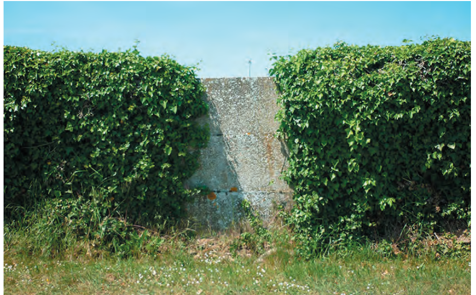
Mur en palplanche de béton gagné par le lierre. Cimetière de Ferrières (60).
