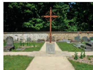
À Boissettes (77), le choix de rénovation des allées s'est porté vers le stabilisé pour des raisons budgétaires. Un sol plus noble en pavé de grès a été réalisé au pied du calvaire, à la rencontre des deux allées principales.
