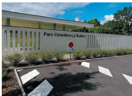
Devant le cimetière-parc de la Teulère à Lescar (64), deux places PMR prennent place au plus près de l'entrée. Un balisage à la peinture identifie la bande de 80cm, rendant le repérage pour la manœuvre du véhicule plus aisé.
