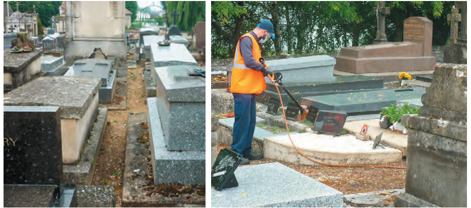
Les espaces résiduels représentent parfois des surfaces conséquentes et difficiles d'accès pour les agents en charge de l'entretien. Cimetière de Nangis (77).
