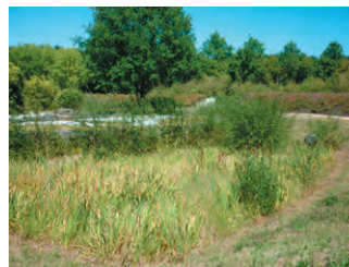
Créer une zone humide quand le site le permet est une belle opportunité à saisir pour enrichir la biodiversité. Espace de récolte des eaux pluviales au nouveau cimetière de Saint-Jean-de Braye (45).
