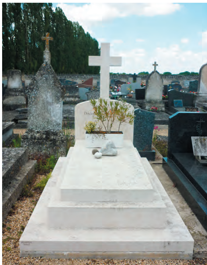
Ensemble réalisé en pierre calcaire locale à Avilly-Saint-Léonard (60). Une cohérence de matériau, une logique de circuit court et d'économie locale à favoriser. Ce matériau, une fois patiné, s'harmonisera mieux avec les tonalités du paysage rural, avec les vieux murs et les anciennes tombes.
