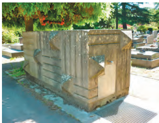
Cimetière Robert Auzelle à Clamart (92). Dans ce cimetière classé, un "buffet" massif sert au stockage des contenants et au point d'eau pour l'arrosage.
