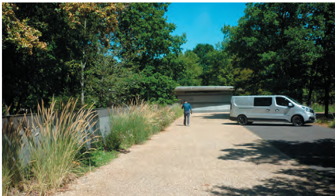
Parking du cimetière de Frédeville à Saint-Jean-de-Bray (45). Le parking principal, près de l'entrée et plus utilisé (photo de gauche), est en béton et enrobé, alors que les espaces plus éloignés sont végétalisés avec un renforcement en "nid d'abeille" (photo prise en période de sécheresse).
