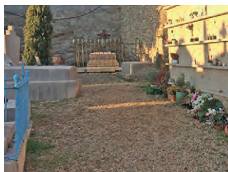
À Sète (34), le parvis et l'allée principale sont en pavés de pierre naturelle posés sur sable et les contre-allées en gravillon, malgré la pente.
