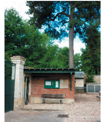
À Évecquemont (95), un simple mur de brique au droit de l'entrée soutient une toiture légère et marque l'entrée du cimetière. L'ensemble abrite les panneaux d'information ainsi qu'un banc.
