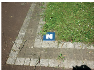
Caniveaux en pavé béton bordant les allées principales en enrobé. Des carreaux émaillés permettent le repérage des différents carrés. Cimetière paysager de Guyancourt (78).
