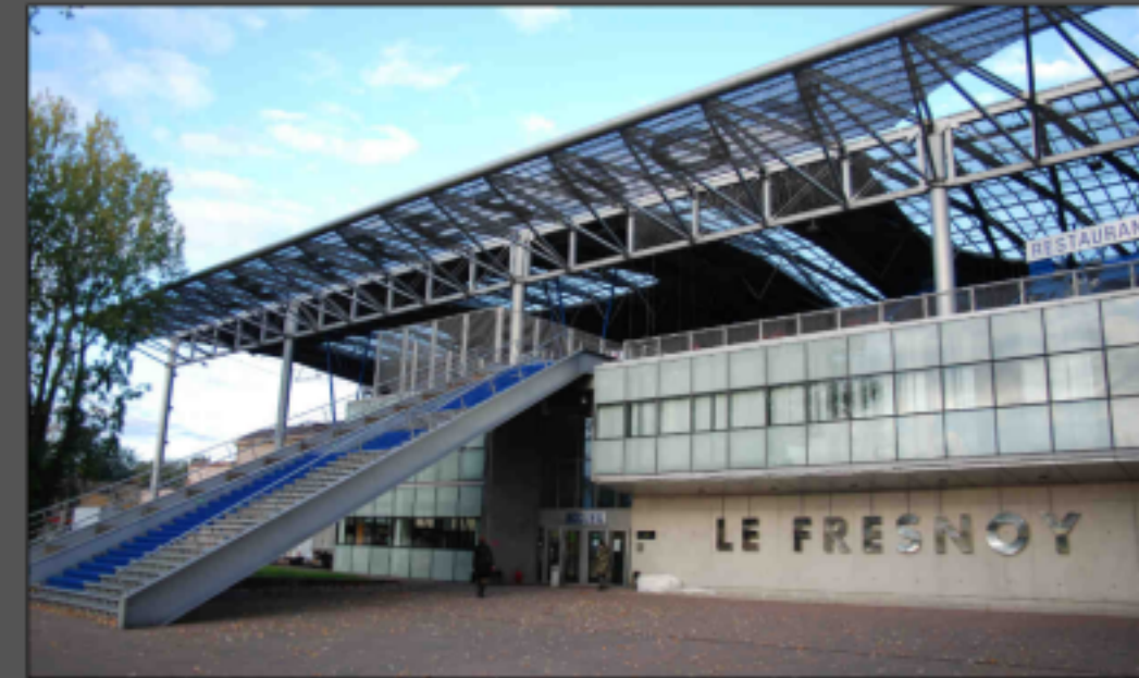
La façade d'accueil ©Ch.Rouvres-CAUE du Nord
