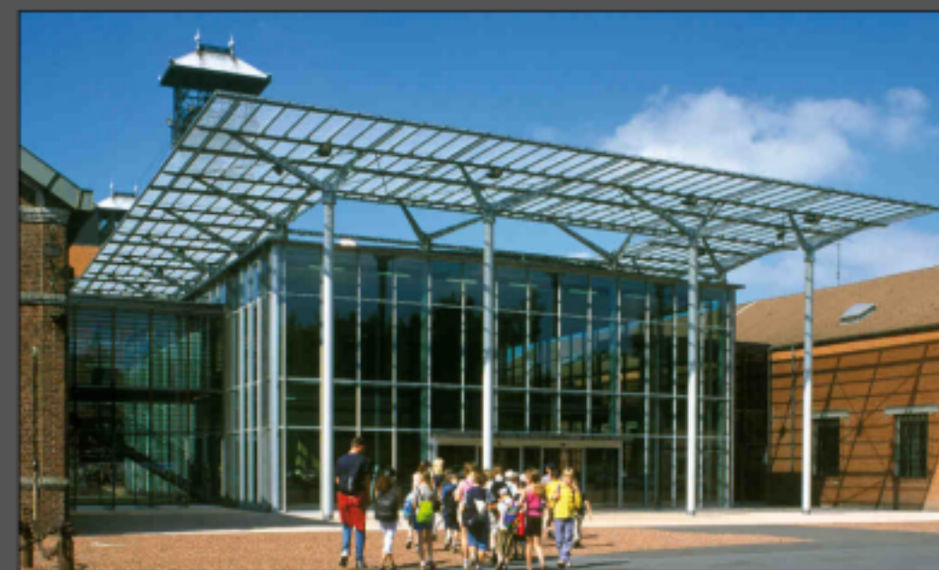
Bâtiment d'accueil ©Centre Historique Minier
