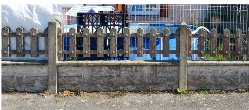
L'assemblage de la maçonnerie traditionnelle et du bois...
