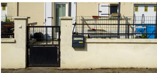
Des murets en maçonnerie surmontés de leurs grillages...
