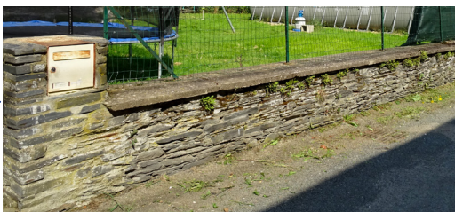
Des murs en maçonnerie de moellons d'ardoises...
