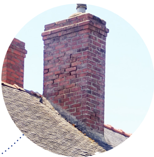
Cheminée en briques
