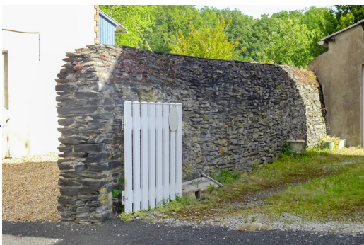
Des murs en maçonnerie de moellons d'ardoises...
