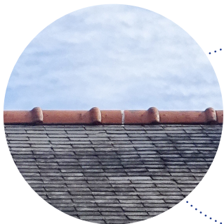
Faitage en tuiles canal
