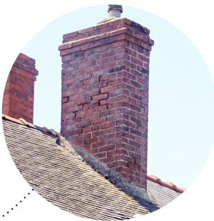
Cheminée en briques
