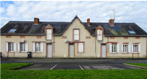
Maisons de contremaîtres
