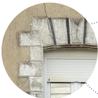
Modénatures moulages ciment imitant la pierre de taille
