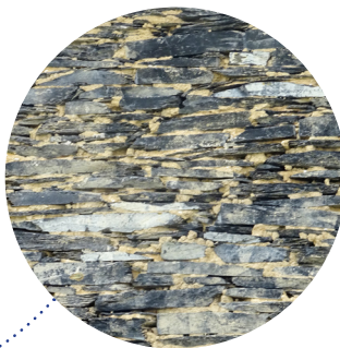
Mur de schiste ardoisier
