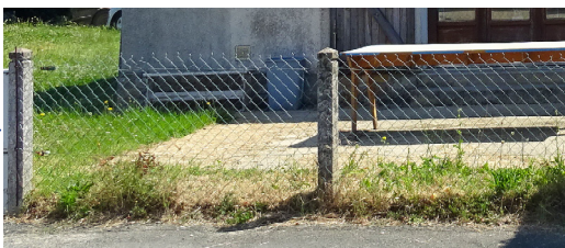
Des clôtures avec des potelets béton et leurs grillages...
