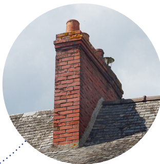
Cheminée en briques
