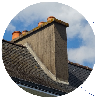
Cheminée en béton
