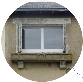
Encadrement et jardinière béton
