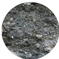
paroi béton parpaings ou mâchefer enduit ciment
