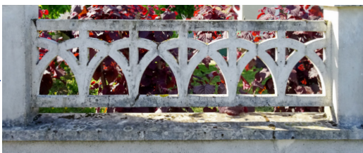
L'assemblage de la maçonnerie traditionnelle, avec des motifs singuliers en béton...
