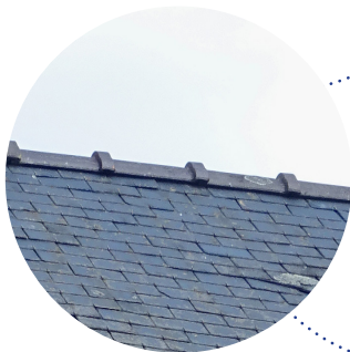
Faitage en métal
