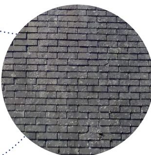
Couverture en ardoises
