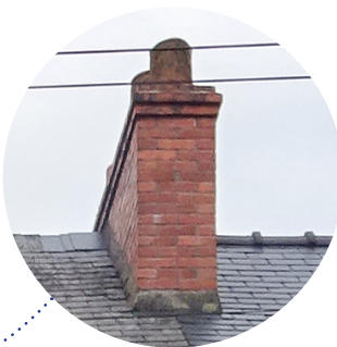
Cheminée en briques
