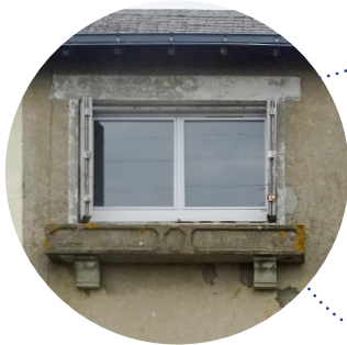
Encadrement et jardinière béton
