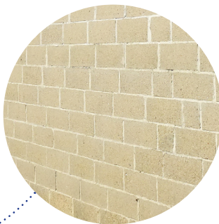
Mur de parpaings
