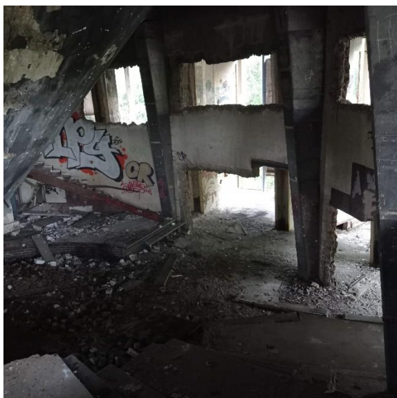
Le premier étage vu du deuxième étage
