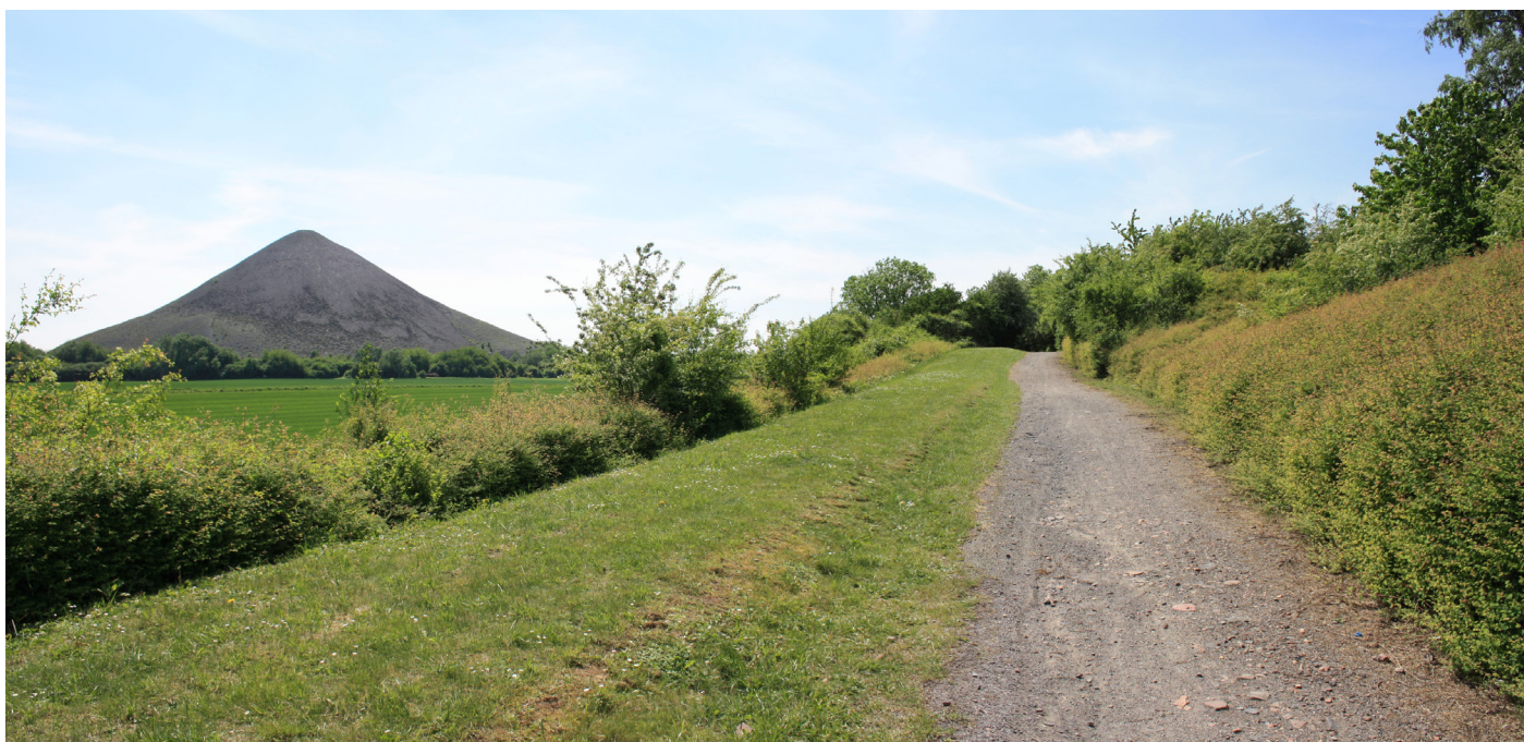
Exemple sur le tronçon 135_06 de la Voie ferrée Fosse24 de Courrières-Lavoir de Fouquières
