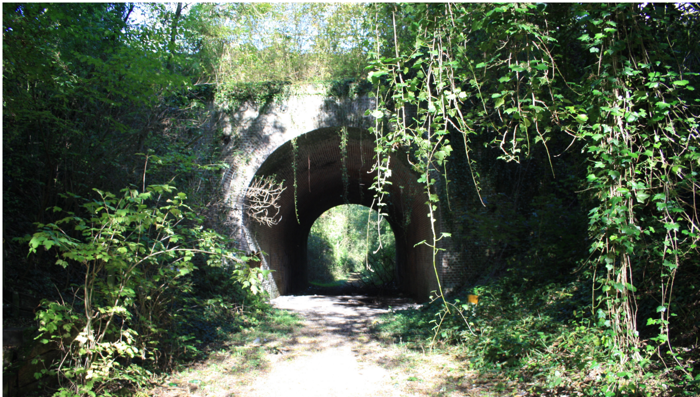
Vue depuis la voie ferrée en remblais
