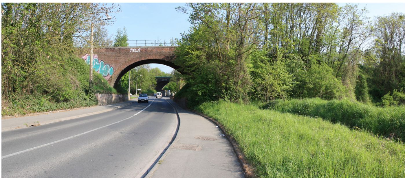
Vue depuis la route passant sous le tronçon 040_01
