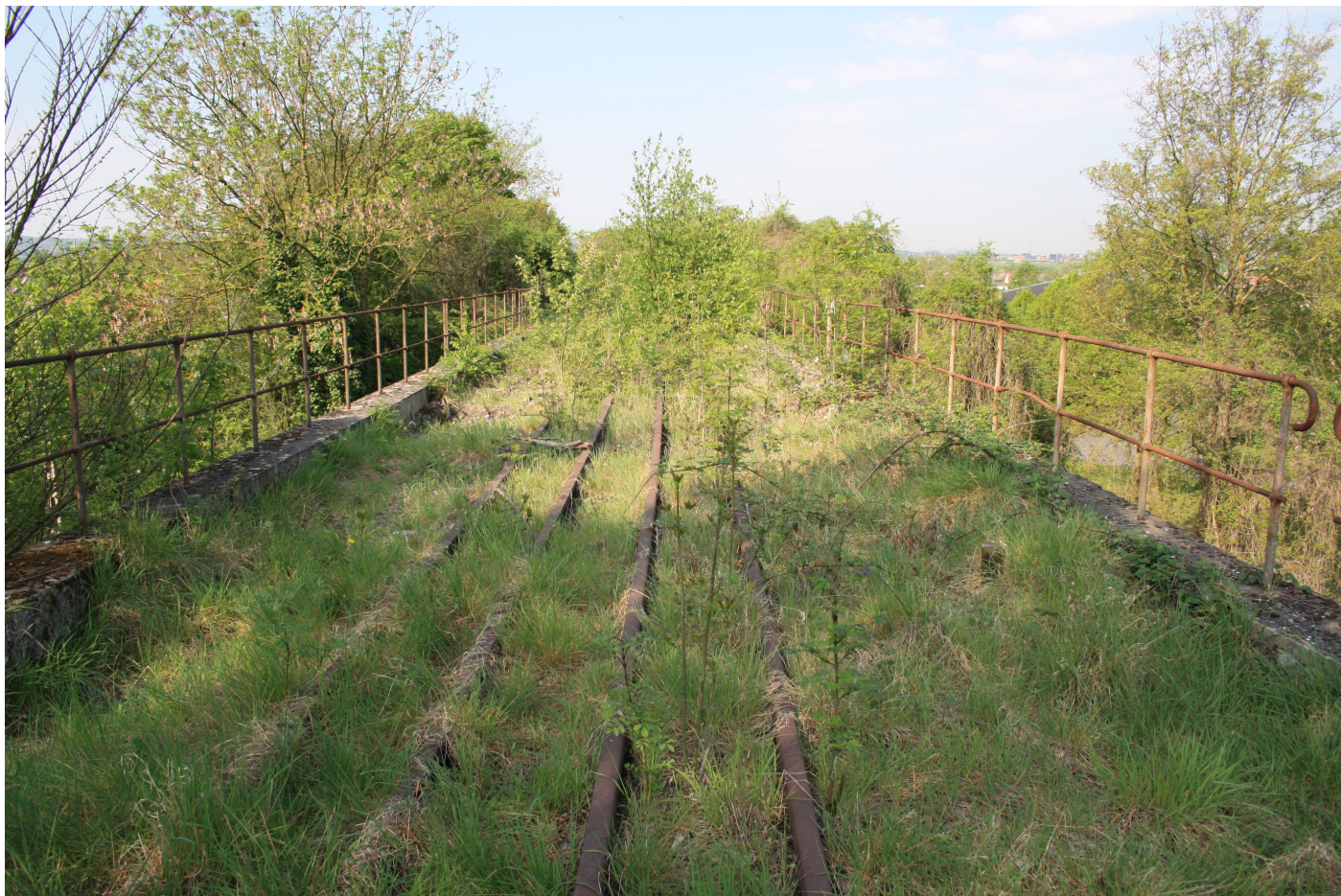
Vue depuis la voie ferrée au niveau du pont rail
