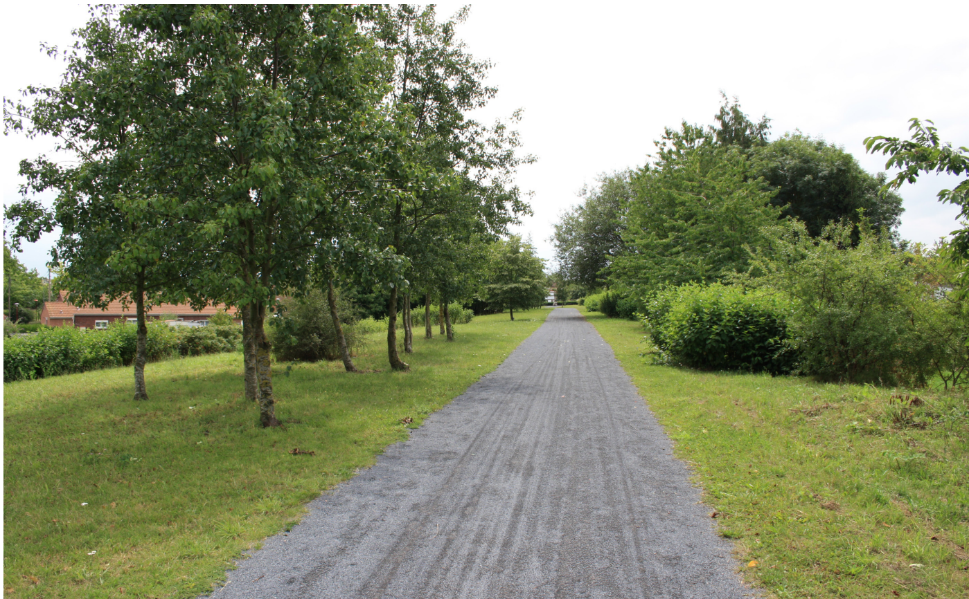
Exemple sur le tronçon 211_14 de la Voie ferrée Sud Concession (Aniche)
