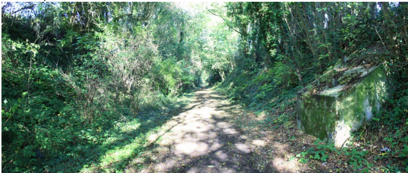
Exemple sur le tronçon 024_08 de la Voie ferrée Fosse5 de Bruay-[voie ferrée fosse1-gare de fouquereuil]
