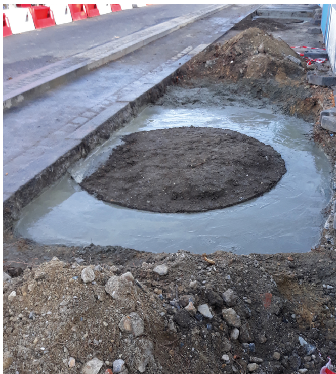
Figure 4 – Exemple de dalle de répartition (RD20 - Pantin)
