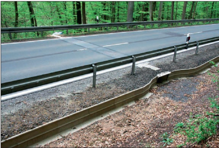
Figuur 22: Amfibieëntunnel. Een verticale geleidingswand zorgt er voor dat amfibieën niet op het wegdek kunnen raken. Ze kunnen de weg kruisen via een kleine tunnel met enkele verlichtingsgaten. De geleidingswand moet regelmatig schoon gehouden worden zodat amfibieën er niet over kunnen klimmen (foto www.aco.fr ).
