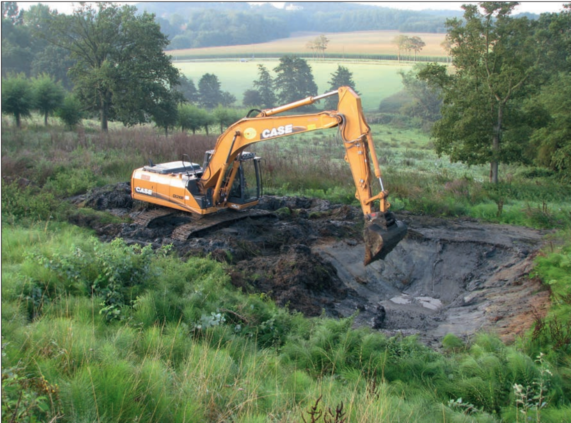
Figuur 12: Ruimen van een poel = de sliblaag uitscheppen tot op de minerale bodem. Het overtollige materiaal wordt meestal in de directe omgeving uitgespreid. Voedselrijk slib kan snel aanleiding geven tot verzuuring. Om dit te vermijden kun je direct het snel groeiende Italiaans raaigras inzaaien (foto: Johan Carette).
