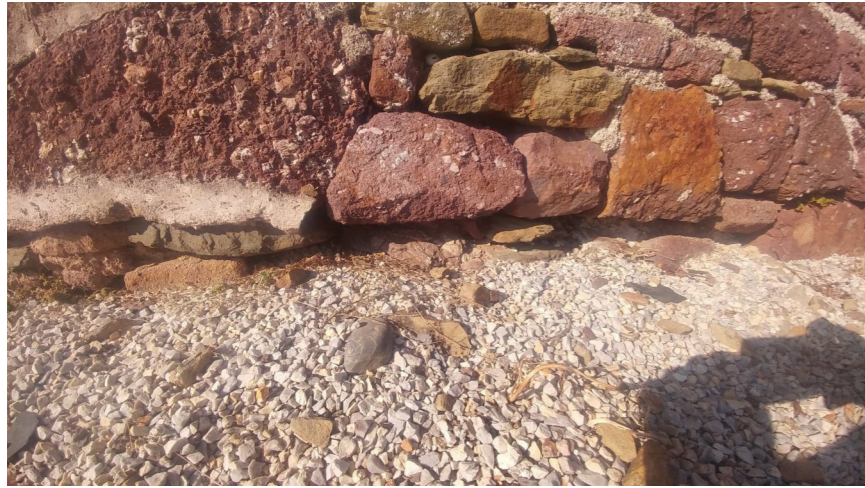
Érosion du pied de mur en poudingue pourré de la chapelle
