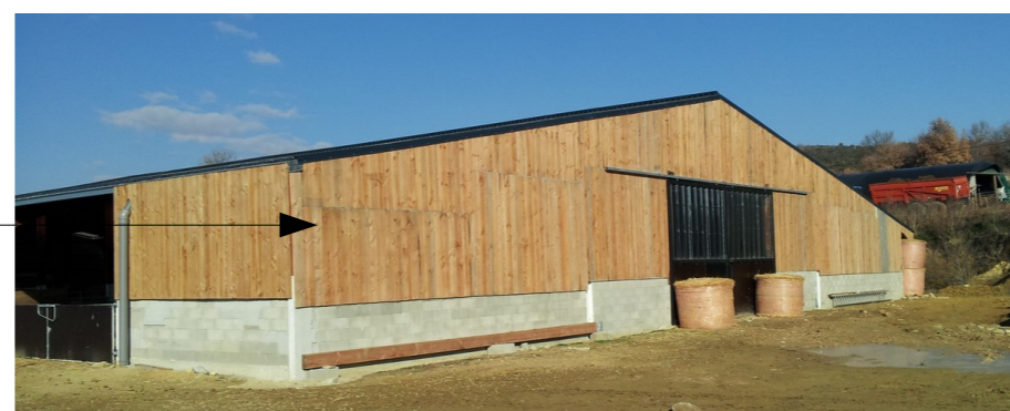
Exemple d'un bâtiment avec bardage bois
