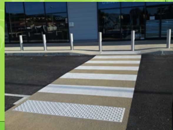
Marquages passages piétons
