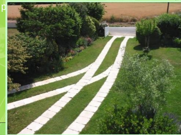
Bandes de roulement en béton
