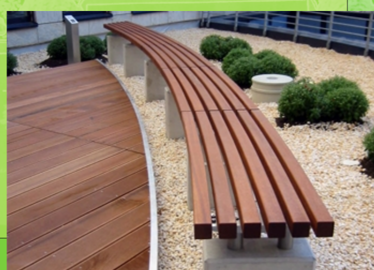
Banc en bois sur plots béton
