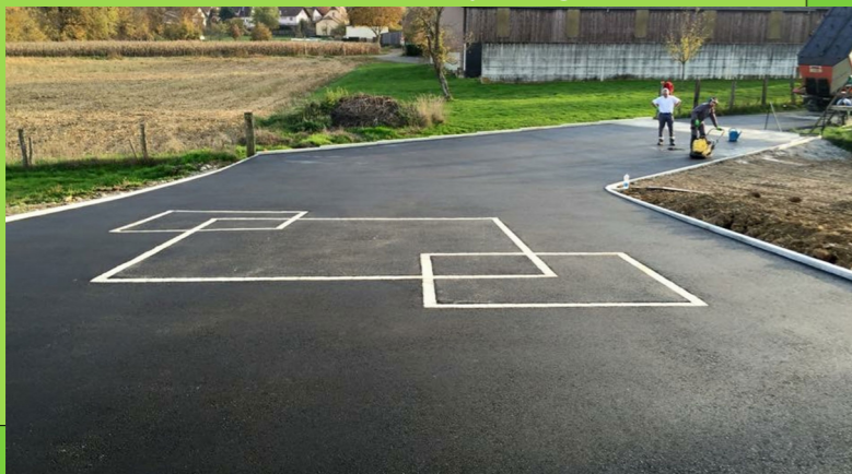
Surface enrobé avec chaînette pavé granit
