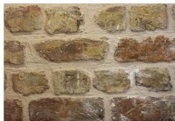
Enduit à la chaux et au sable
