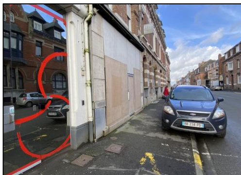
Local vacant nécessitant des travaux – rue Thiers
