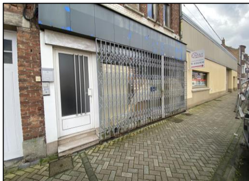
Cellule vacante depuis de nombreuses années – Avenue Clémenceau
